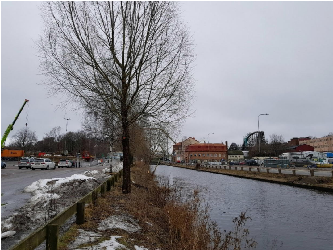
Bild 1. Vy mot norr visar befintlig brant slänt ner mot ån strax norr om Vörtgatan.
